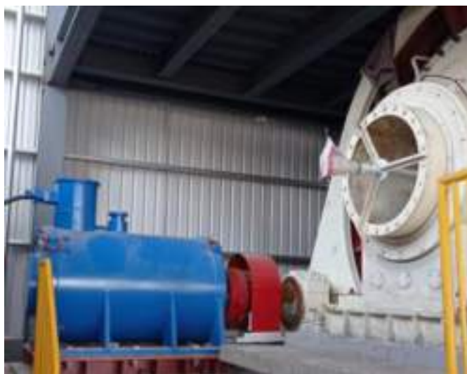
1000kW/10kV 球磨机直驱永磁电机【洛阳盛曼特】
