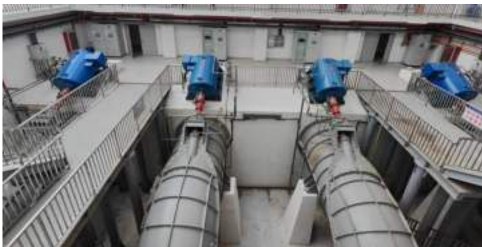
日照东方永磁同步电机直驱形式
